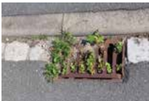
Straßeneinlauf ist stark verunreinigt und verwuchert: Eine Überschwemmung ist vorprogrammiert.
