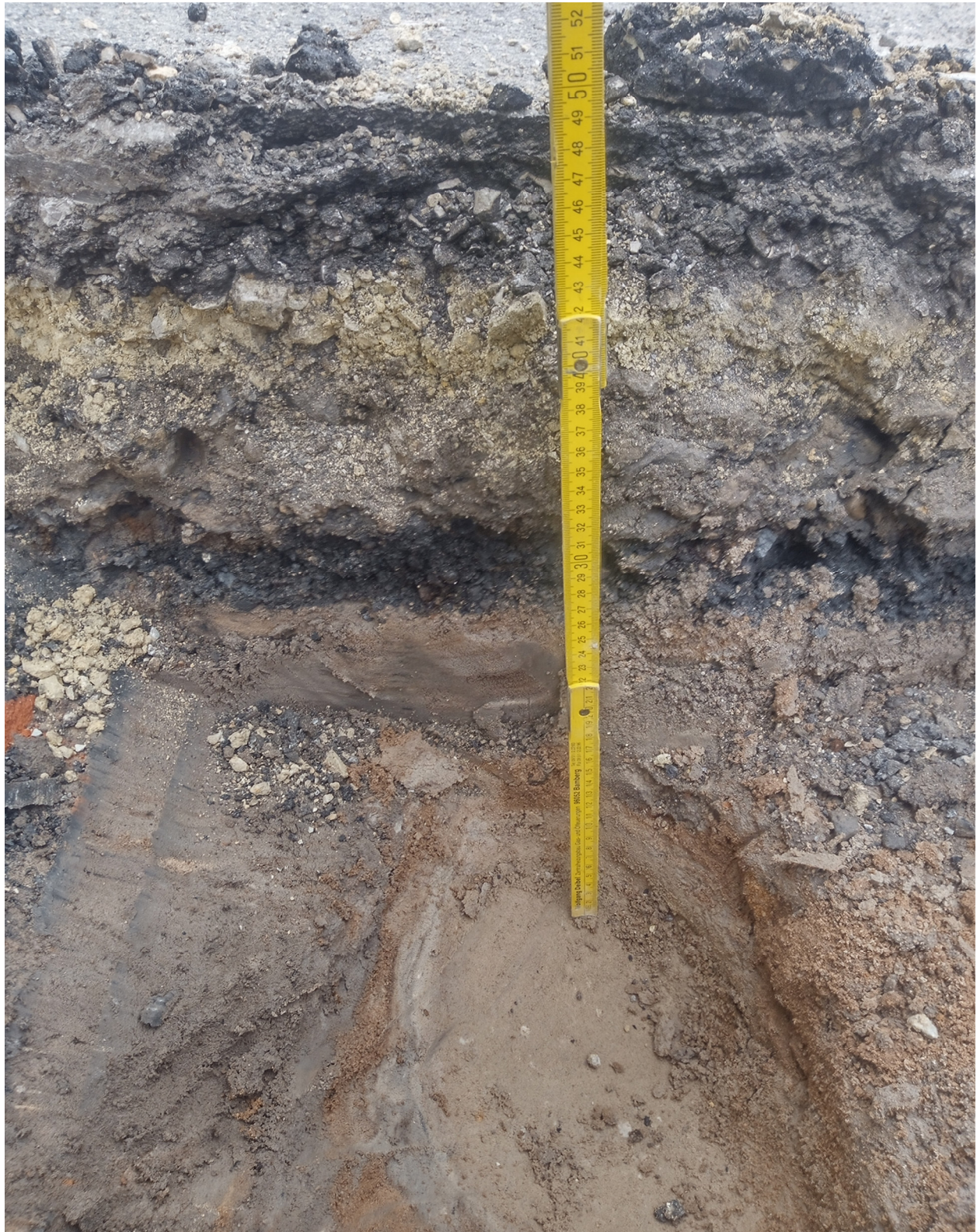
Abb. 1: Blick in den Baggerschurf SCH 4.
