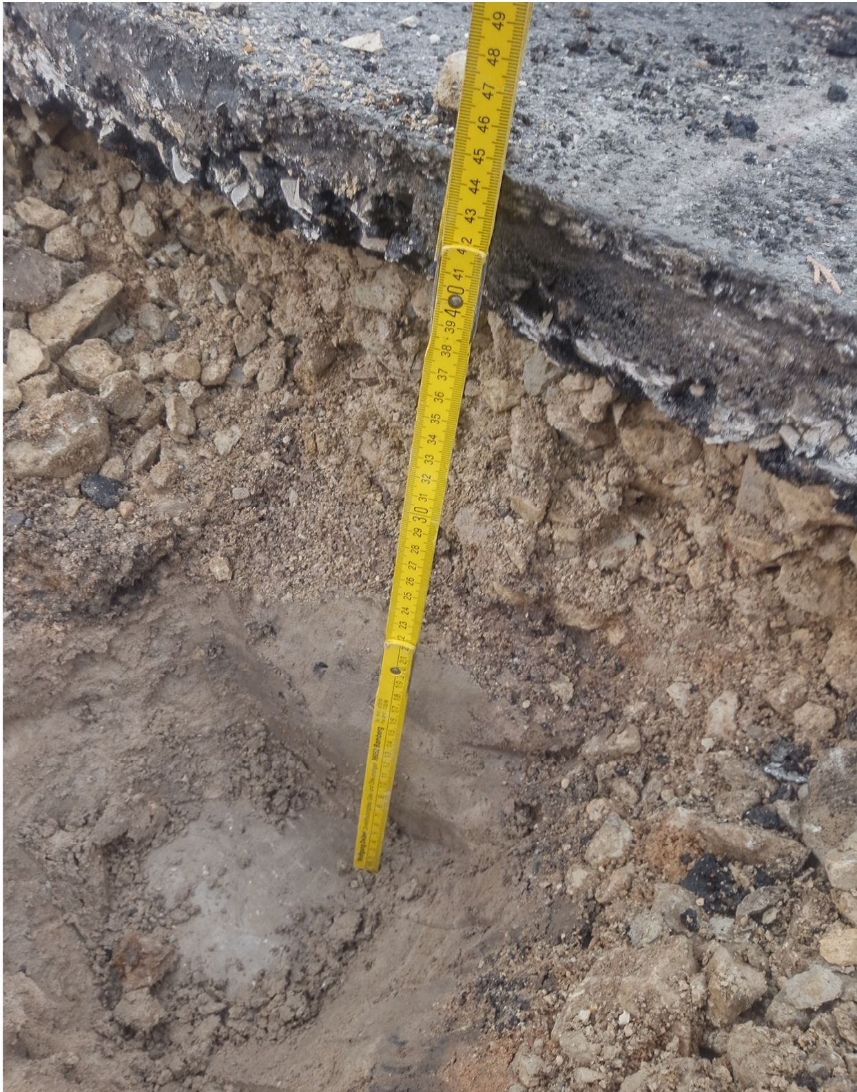
Abb. 1: Blick in den Baggerschurf SCH 5.
