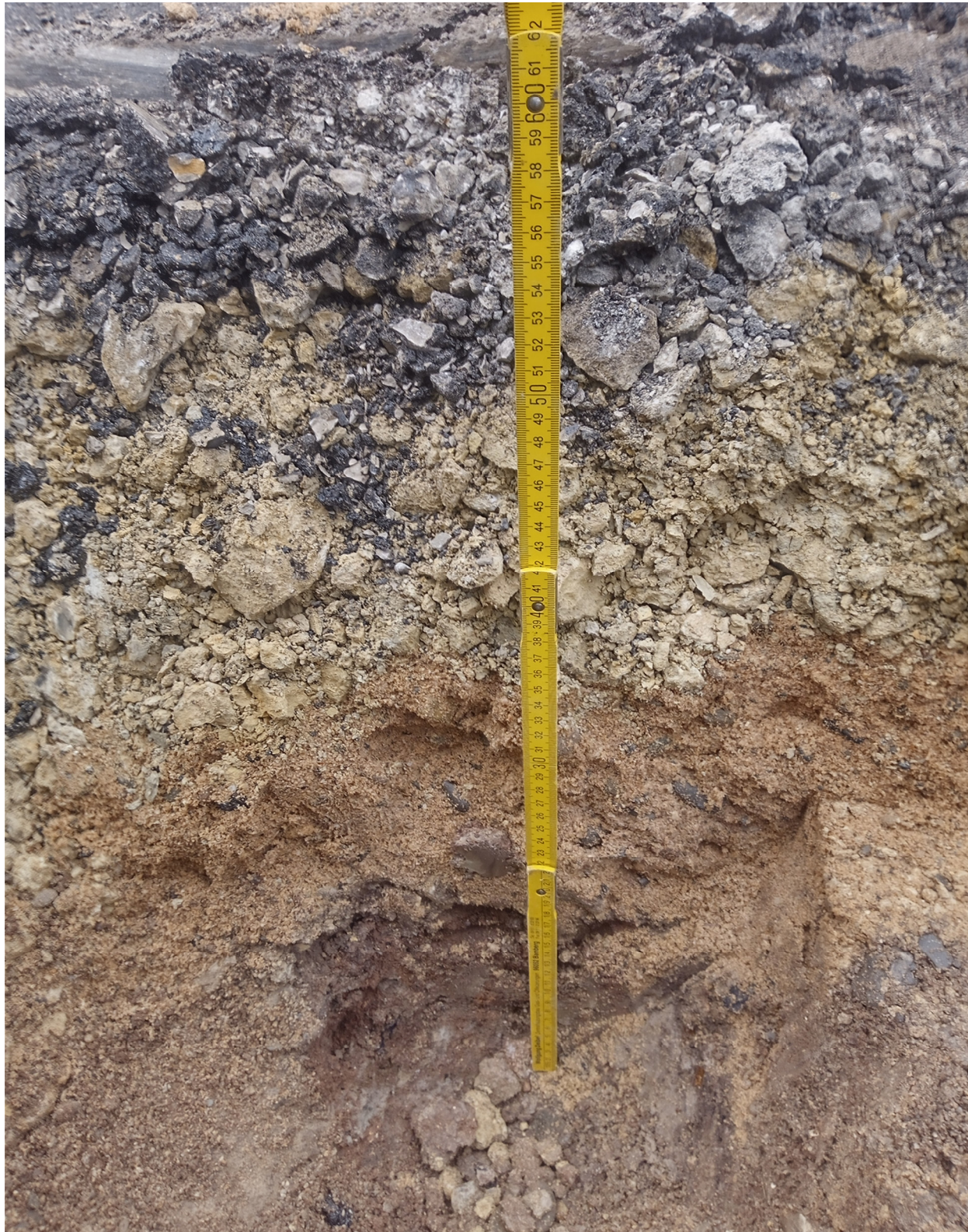
Abb. 1: Blick in den Baggerschurf SCH 6.
