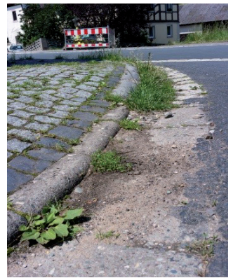
Durch Verunreinigung und Bewuchs wird der Abfluss hier stark gehemmt.
