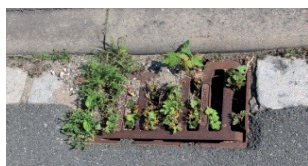
Straßeneinlauf ist stark verunreinigt und verwuchert: Eine Überschwemmung ist vorprogrammiert
