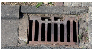
Gelegter Straßeneinlauf: Der Abfluss von Regenwasser ist gewährleistet
