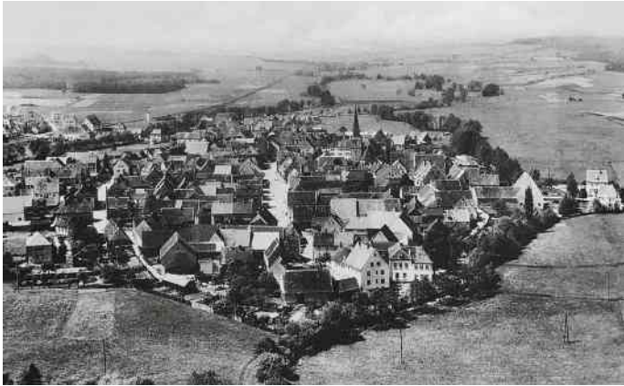
Ansicht Burgebrach, historisches Luftbild um 1955 Quelle: Burgebrach wie es einmal war, Band 2, Rudi Fischer, Geiger-Verlag, Horb am Neckar, 1992
